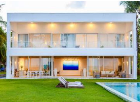
CASA NÃH PRAIA MACEIÓ - AL
