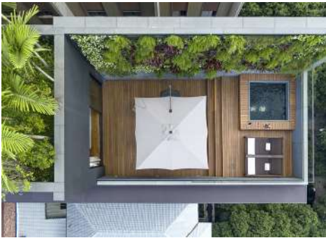
HOTEL FASANO BELO HORIZONTE - MG
